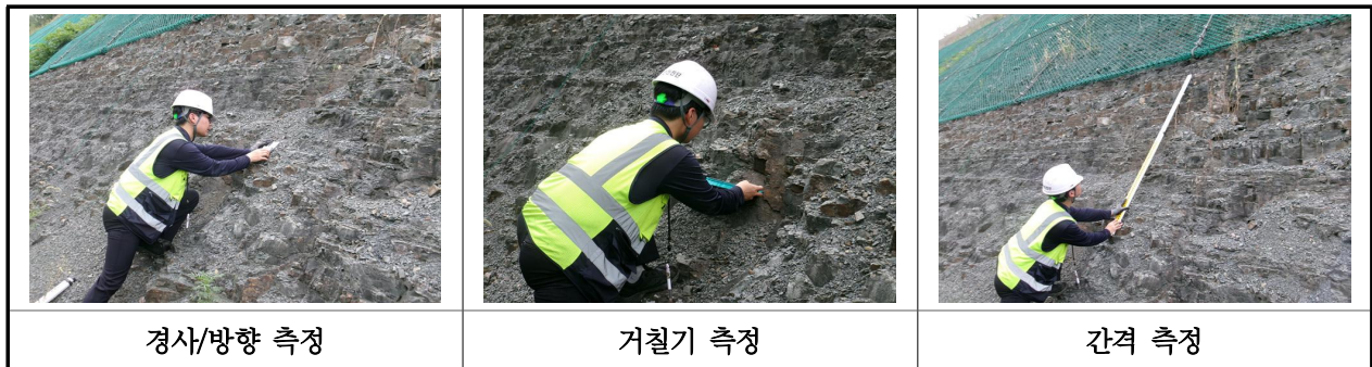
【사진 58.3.3】 불연속면 측정 현황
